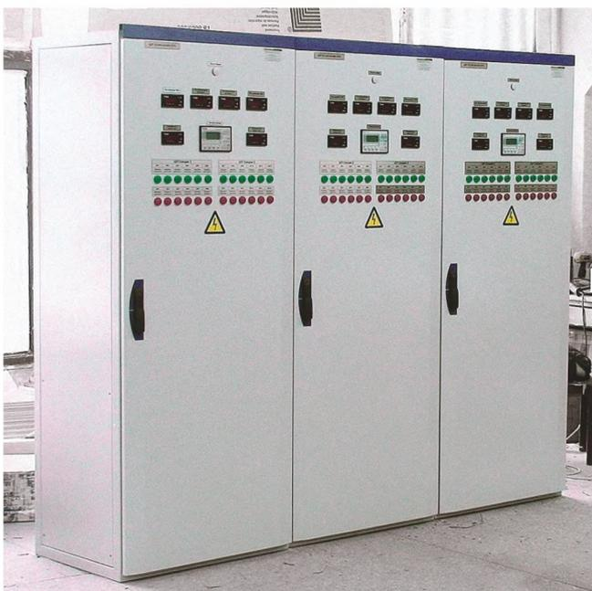
Щит постоянного тока применяется для ввода и распределения электрической энергии от основных источников (зарядно-выпрямительных устройств) в нормальном режиме и от резервных источников (аккумуляторных батарей) при исчезновении напряжения переменного тока или при отказе зарядно-выпрямительных устройств.
